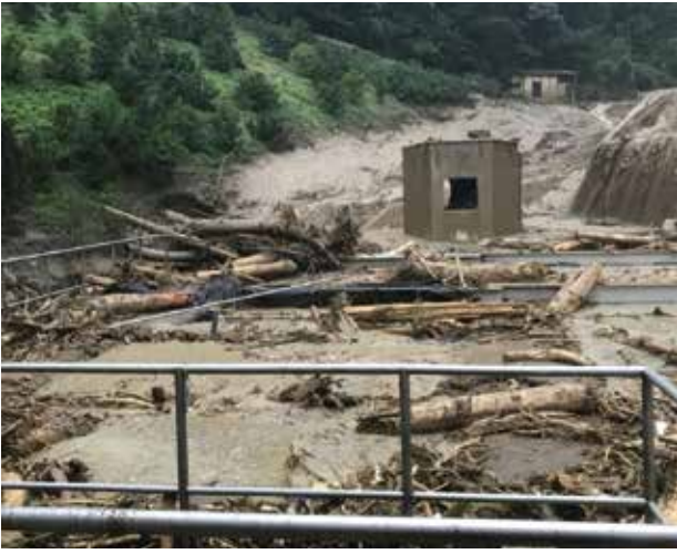
浄水場に押し寄せた土石流 (南予水道企業団提供)
