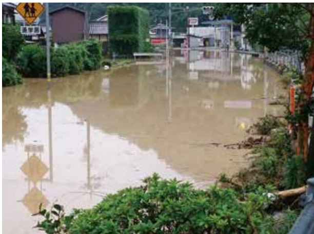
国安川から溢れた水で、国道56号線が冠水（市民提供）
