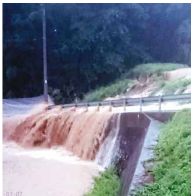
降雨により決壊したため池 (鳥首池) (市民提供)
