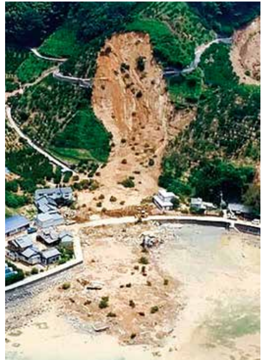
崩落した土砂が堤防を越えて道に流出するなど、被害の凄まじさがうかがえる（愛媛新聞：平成30年7月24日） P21 D-3
