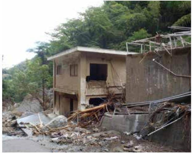
管理棟・急速ろ過池
