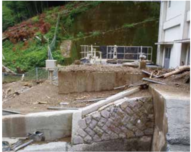
活性炭混和池
