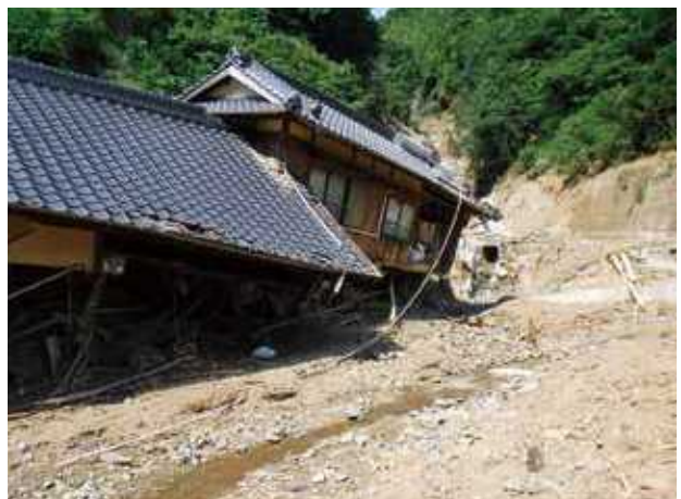
倒壊した家屋
