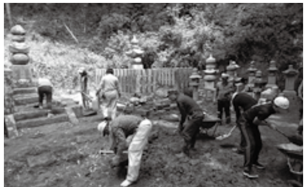
ボランティアによる土砂撤去作業
