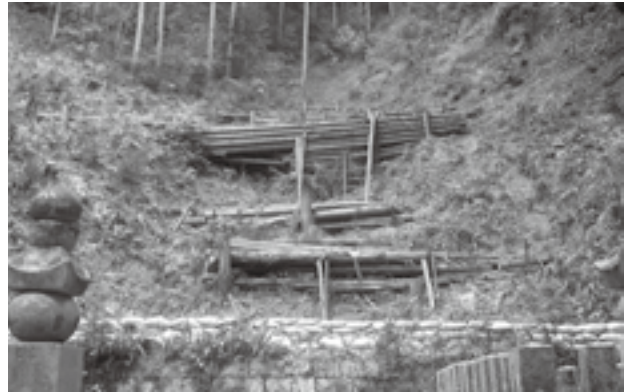
崩落した裏山
