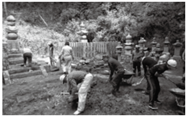
ボランティアによる土砂撤去作業
