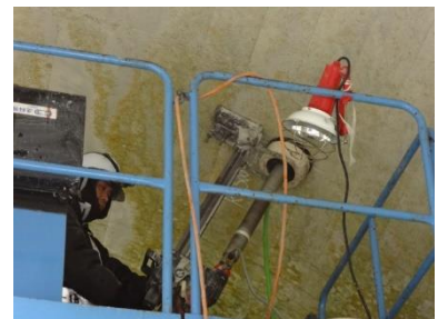
コア削孔による調査
