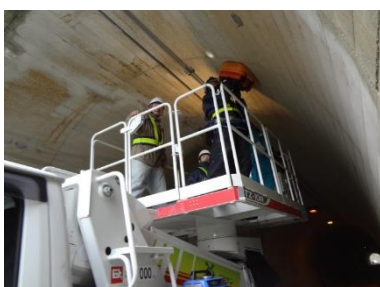
高所作業車による点検状況
