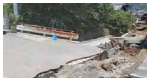
道路・橋の崩壊
