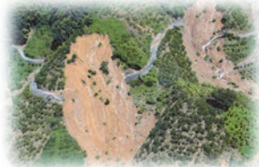
園地崩落（白浦地区）
