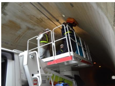
高所作業車による点検状況
