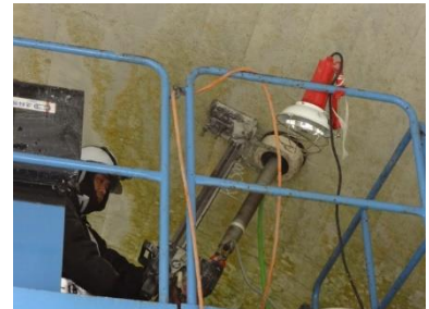
コア削孔による調査
