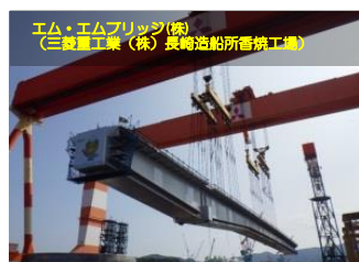
クレーンによる浜出し （側径間ブロック）
