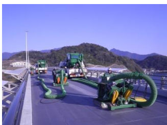
鋼床版の表面処理
