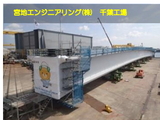
中央径間ブロック
