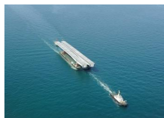
海上輸送（側径間ブロック）
