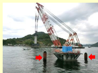
据付状況（矢印は導杭）
