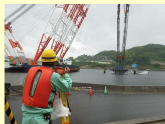
据付確認状況
