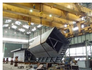
箱組立後の反転作業
