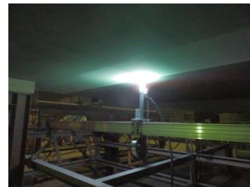
金属溶射状況
