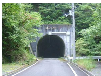
篠山トンネル
