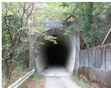
梨ノ木谷隧道
