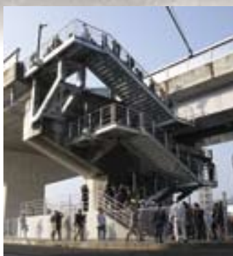
津波一時避難場所 (国道56号線宇和島道路架橋)
