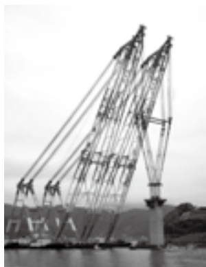
(橋脚設置工事の様子)
