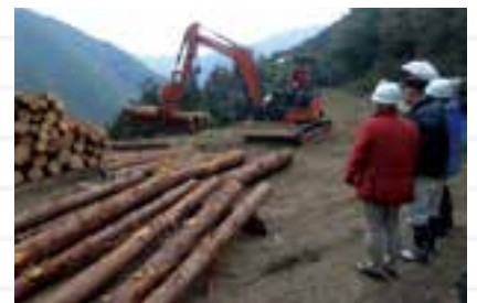
津島町の木材伐採現場の様子
