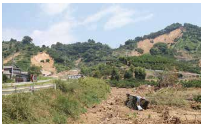
吉田町 白浦地区の被害
