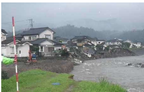
河岸侵食による家屋の倒壊(花月川)
