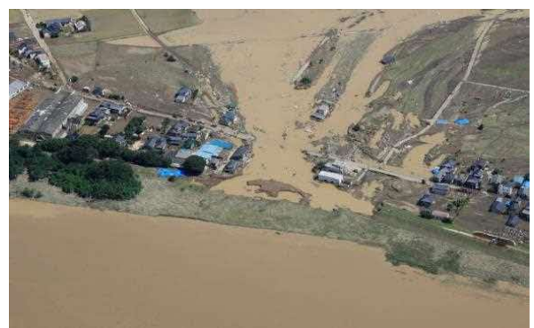
堤防決壊による家屋の流失(鬼怒川)
