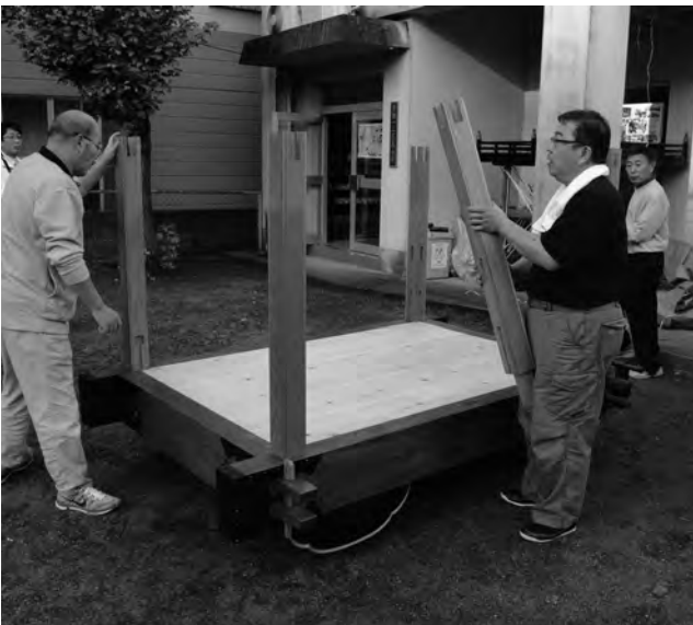
写真5 魚棚二丁目一練車一組立て5
