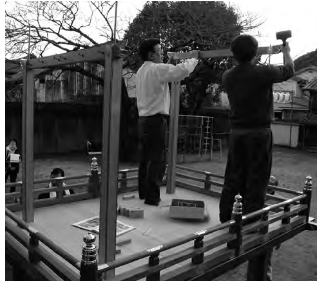
写真8 魚棚二丁目一練車一組立て8
