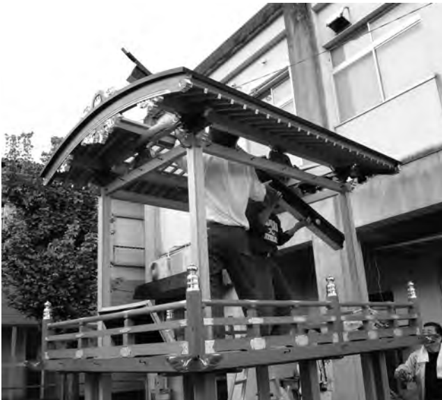
写真11 魚棚二丁目一練車一組立て11
