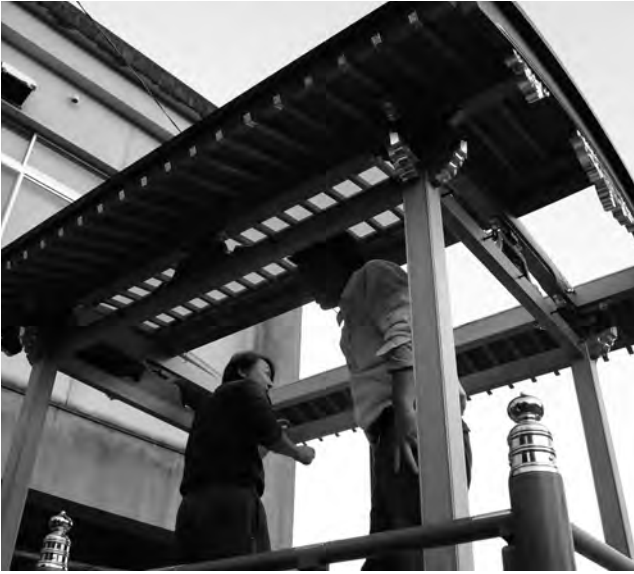
写真10 魚棚二丁目一練車一組立て10
