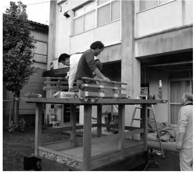
写真7 魚棚二丁目一練車一組立て7
