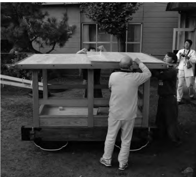
写真6 魚棚二丁目一練車一組立て6
