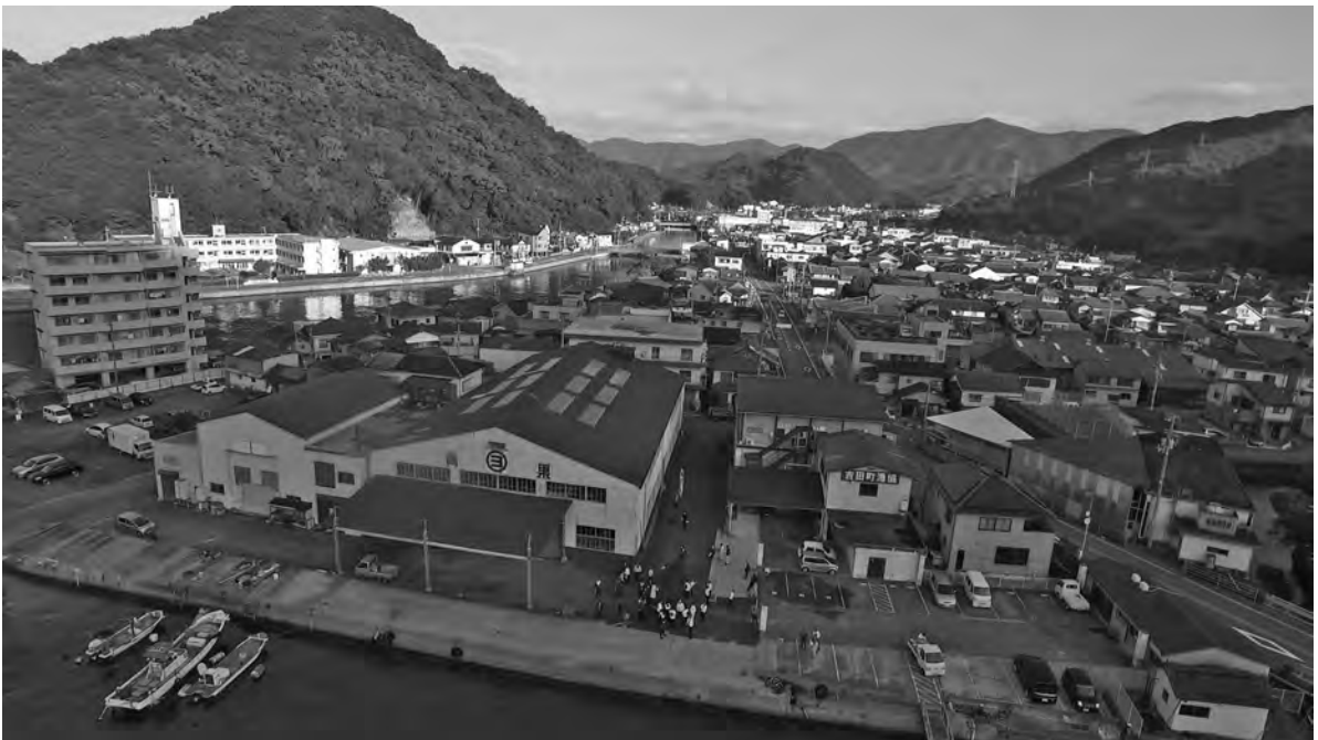
吉田港上空からの写真（平成 28 年 11 月 3 日）
