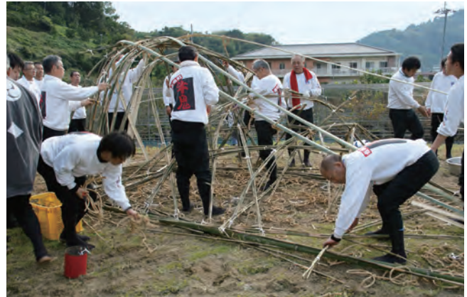
写真 17 胴体の解体 (H29 元町)
