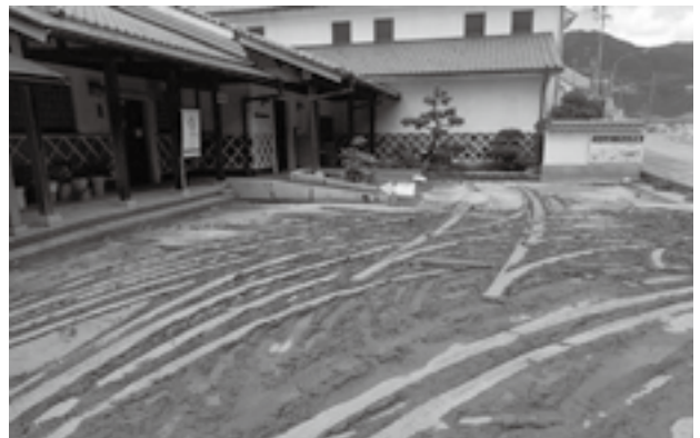
駐車場に大量の土砂が流れ込んだ
