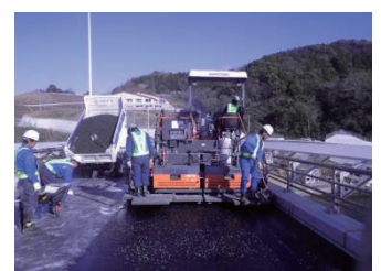
ゲ-スフィニッパによる舗装
