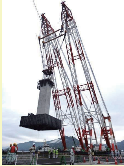
坂下津岸壁での地切り
