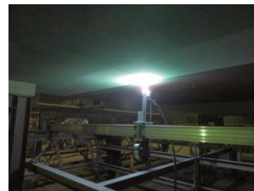
金属溶射状況
