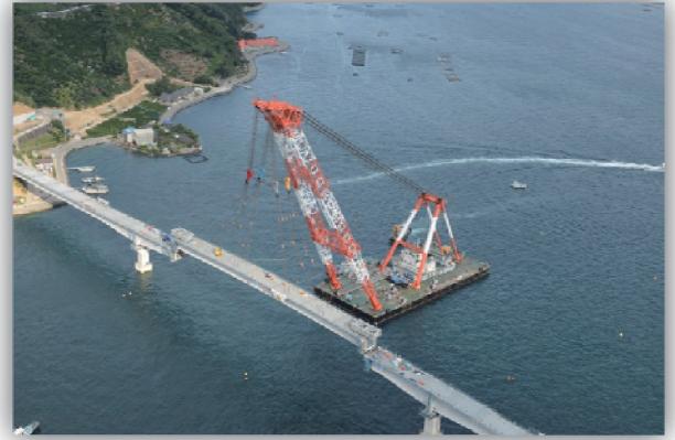
大ブロック架設（中央径間）
