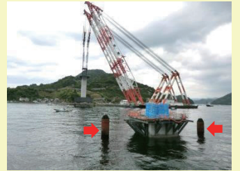
据付状況（矢印は導杭）
