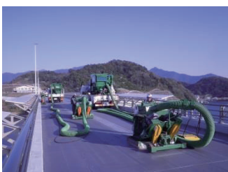
鋼床版の表面処理
