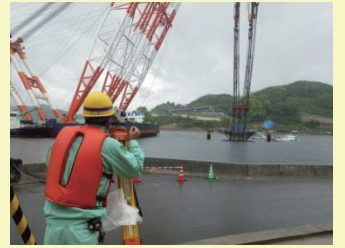
据付確認状況
