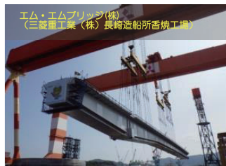
ゴライアスレーンによる浜出し （側径間ブロック）
